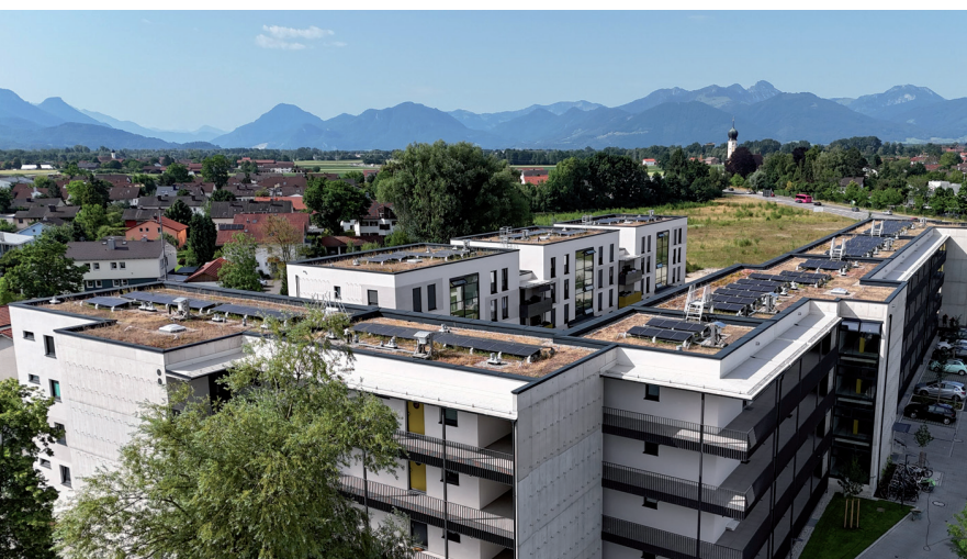
GRWS-Wohnanlage mit PV-Anlage auf dem Dach
